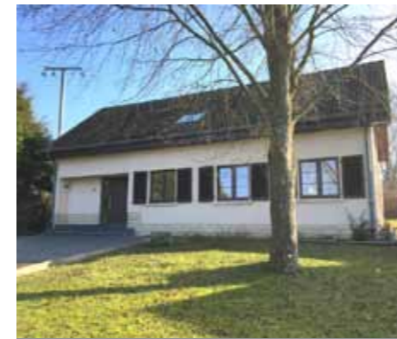
MUNSBACH: maison rénovée, 260 m 2 , 12a, cuis éq, 5ch, 3 sdb, terrasse, jardin, gges € 3.800.-
